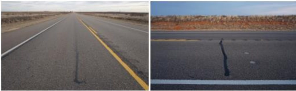
Longitudinal Cracking: 01/10/2018
