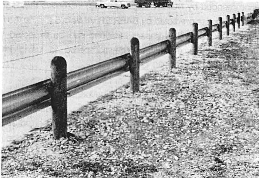
FIGURE 4. OPTIMIZED GUARD FENCE DESIGN WITH 7" ROUND WOOD POSTS
