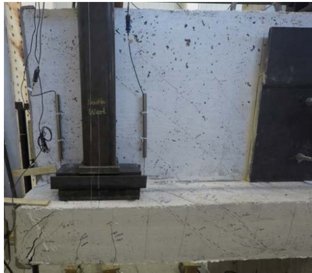
(d) South side at final load level
