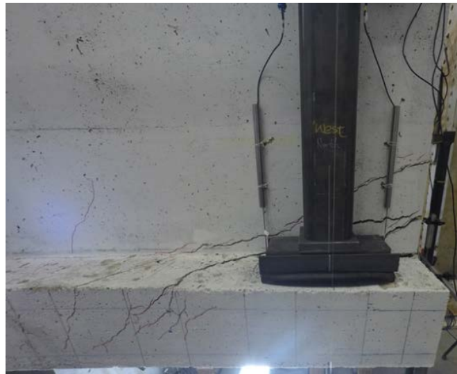
(d) Final load level—north side
