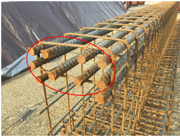
(d) Negative flexure reinforcement
