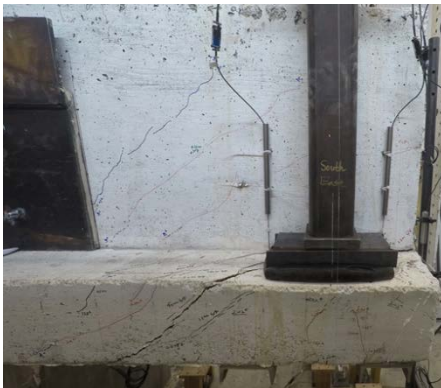
(d) South side at final load level
