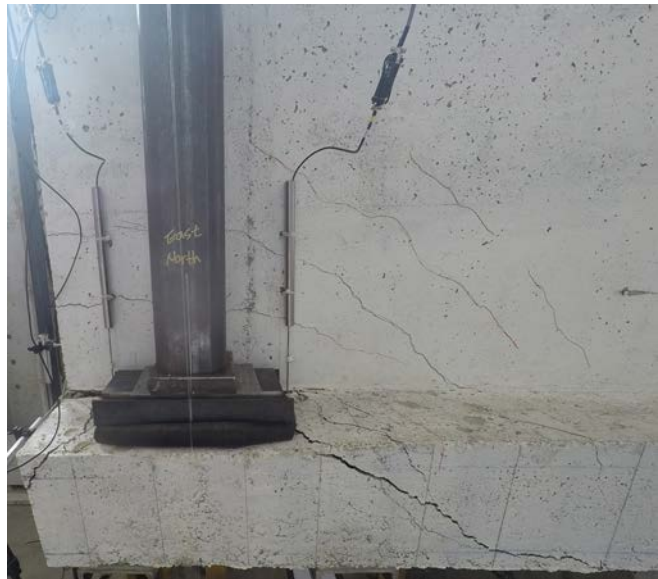
(d) North side at final load level
