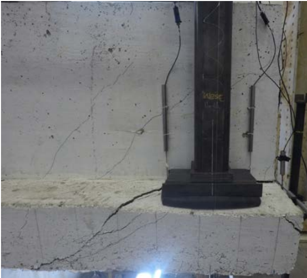
(d) North side at final load level
