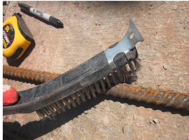
Figure 3.2- (d) Remove stain on rebar
