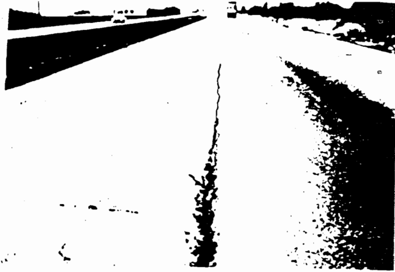
Longitudinal Cracking
