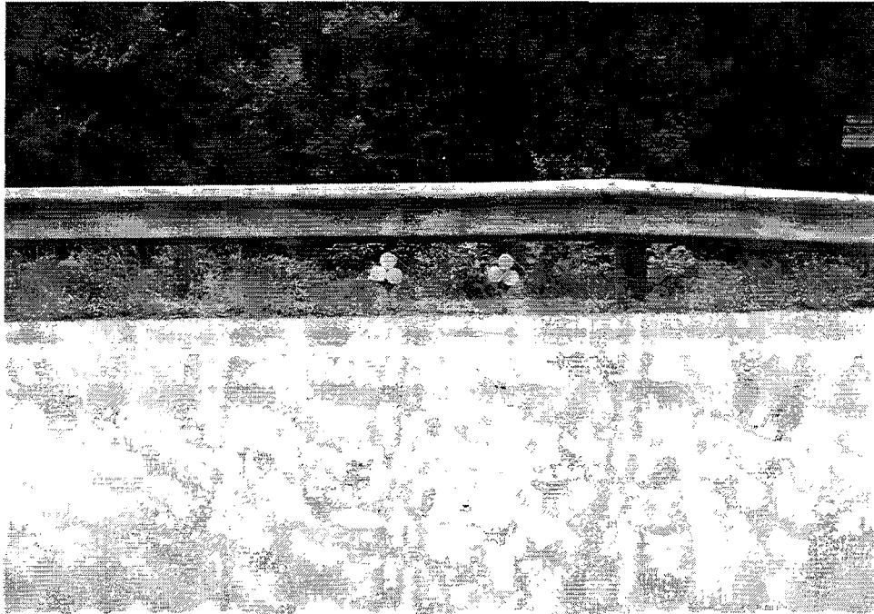
Fig 2.8. Retro-reflector array.
