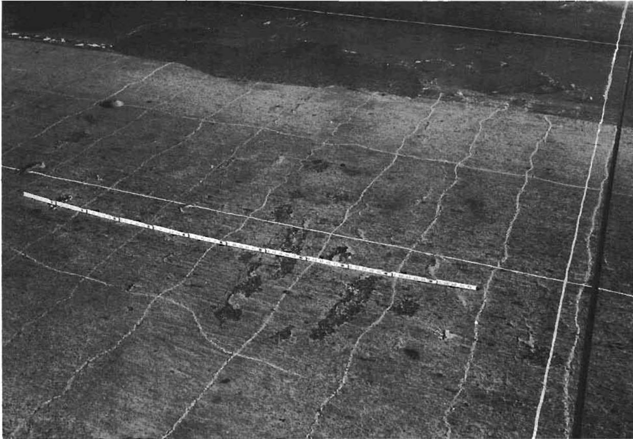
FIGURE 2 LONGITUDIONAL AND TRANSVERSE SLAB CRACKING
