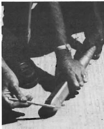
FIG.3: Inspecting a spud vibrator.
