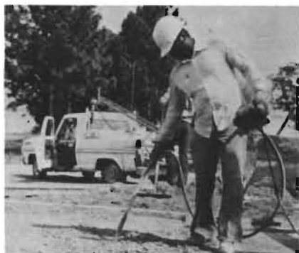
FIG. 5: Angling spud in a thin slab.
