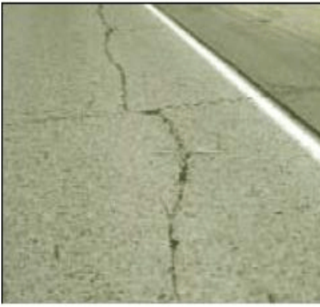
Longitudinal Cracking
