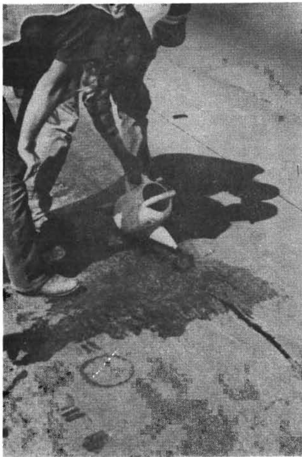
Fig. 2.4 Pouring monomer over sand
