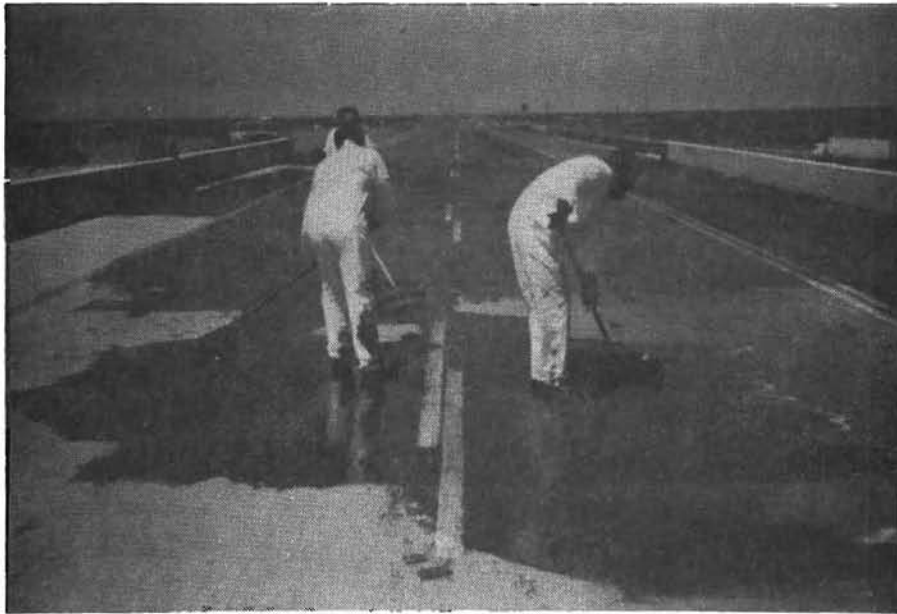
Fig. 5.23 Pouring Sealant Directly Onto the Slab.
