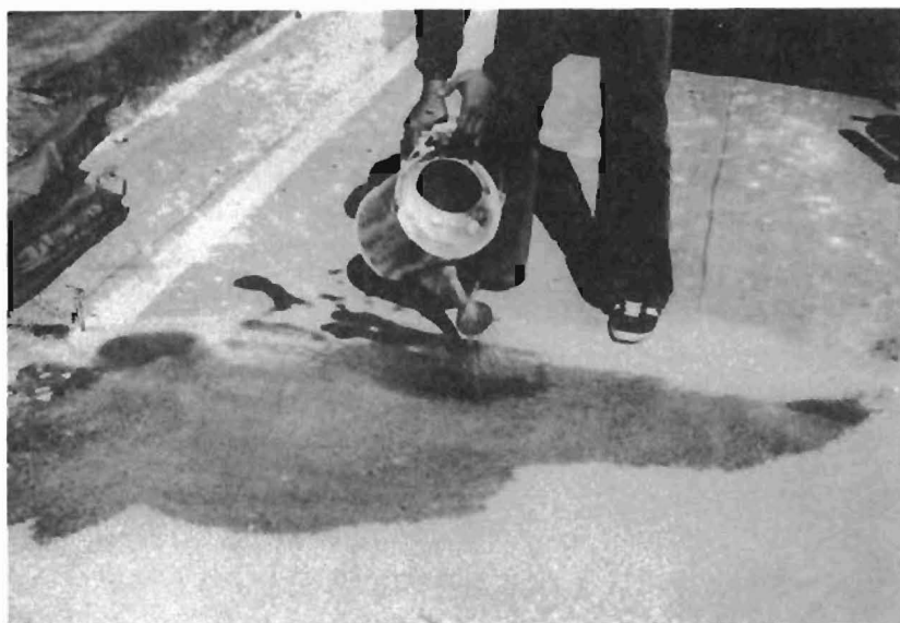
Fig. 4.4b Sprinkling Monomer.
