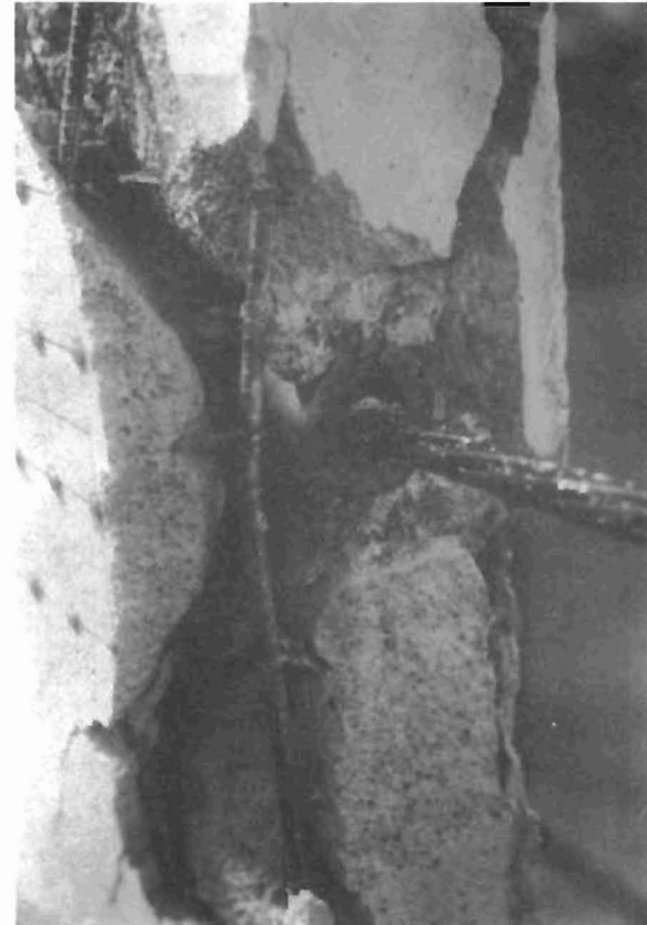
(d) Ultimate failure
