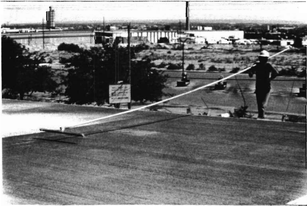
Fig 3.3. Manual texturing of pavement surface (IH10, El Paso, Texas).
