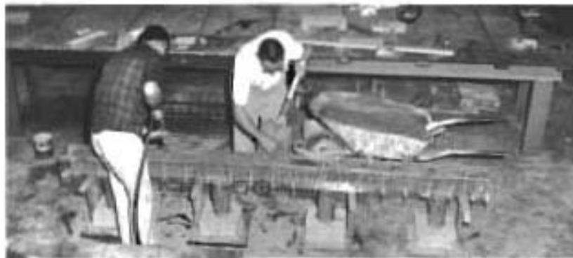
(d) Casting Bent Cap (Four Column Bent).
