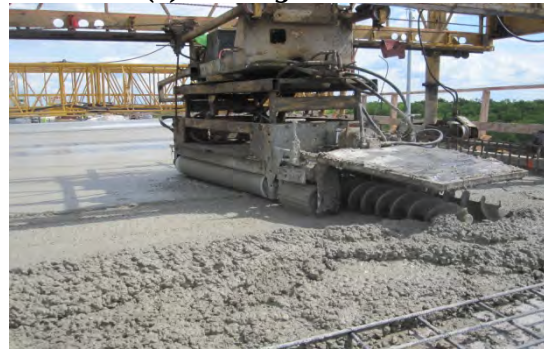
(d) Finishing surface
