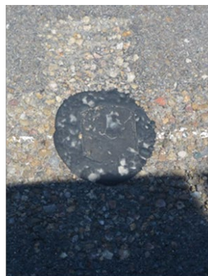
(d) Marker Adhesive Interface
