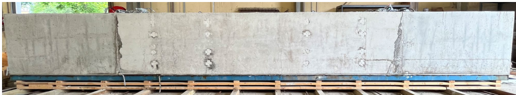
(d) Concrete cast in the exterior section
