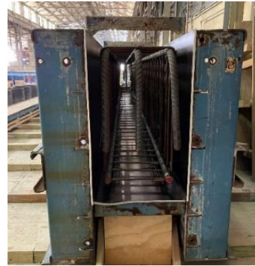
(d) Rebar cage in formwork
