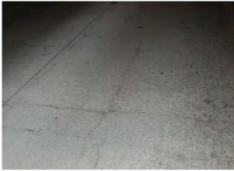
Narrow longitudinal crack
