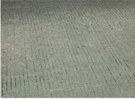
Longitudinal crack
