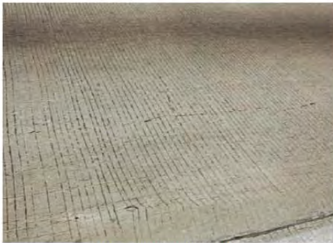
Longitudinal crack
