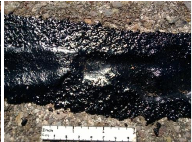
(d) Old Pavement, Route
