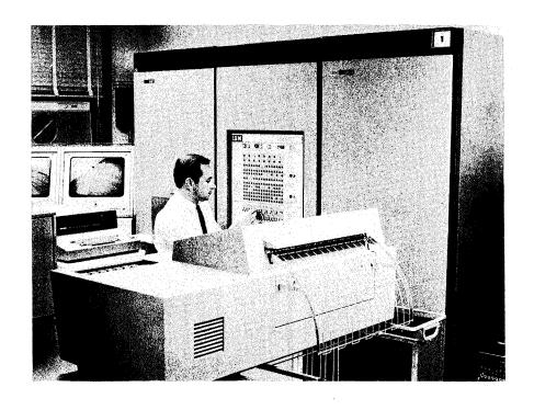
FIGURE 4. DIGITAL COMPUTER DATA ACQUISITION AND CONTROL SYSTEM.
