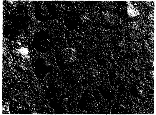
(d) Rating 4. Severe scaling.
