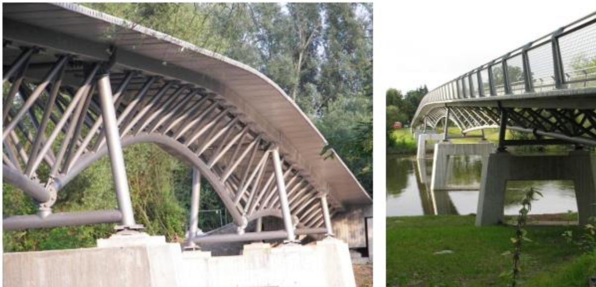
Figure 2.17. Gaertnerplatzbridge in Kassel, Germany (Schmidt 2012).
