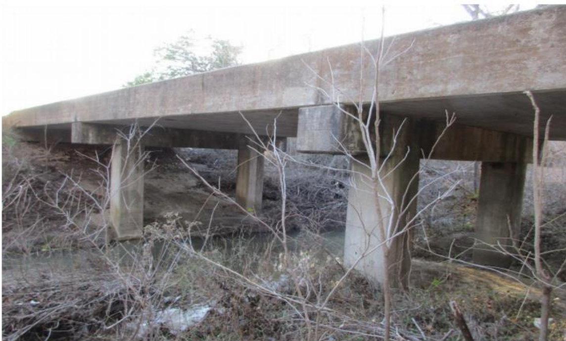
Figure 7.5. Bridge CS-9 (TxDOT 2018c)
