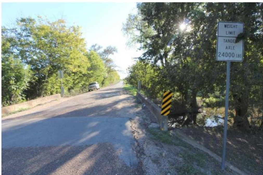
Figure C.11. Bridge CS-6 (TxDOT 2018c)
