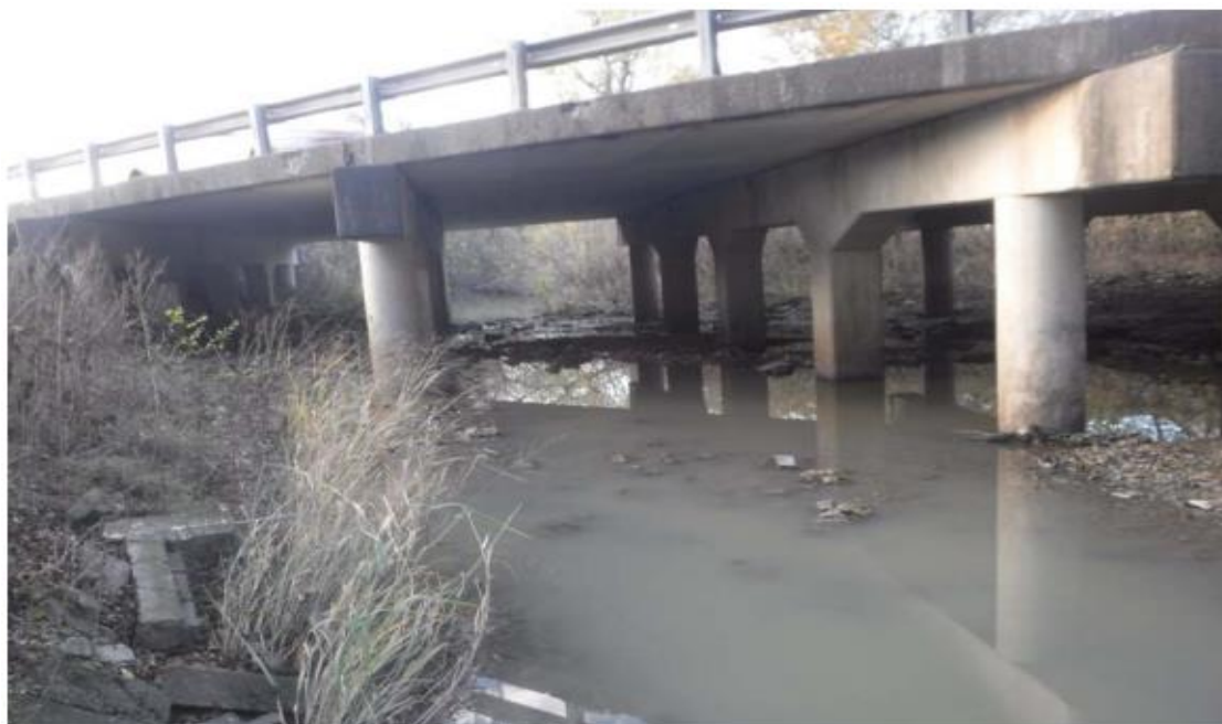
Figure C.7. Bridge CS-4 (TxDOT 2018c)
