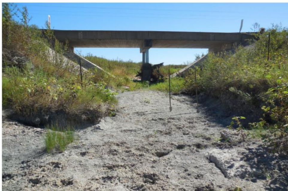
Figure C.23. Bridge CS-12 (TxDOT 2018c)
