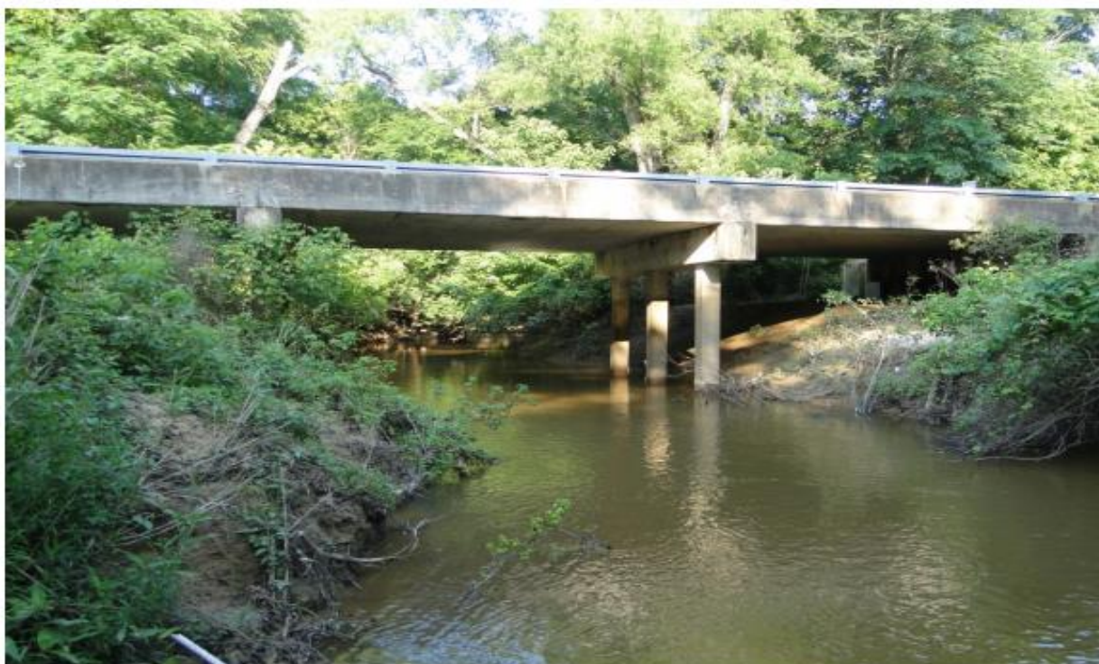
Figure C.27. Bridge CS-14 (TxDOT 2018c)
