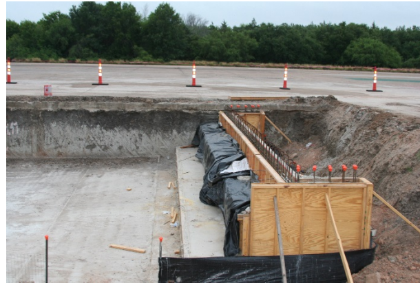
(d) Abutment Concrete Pour
