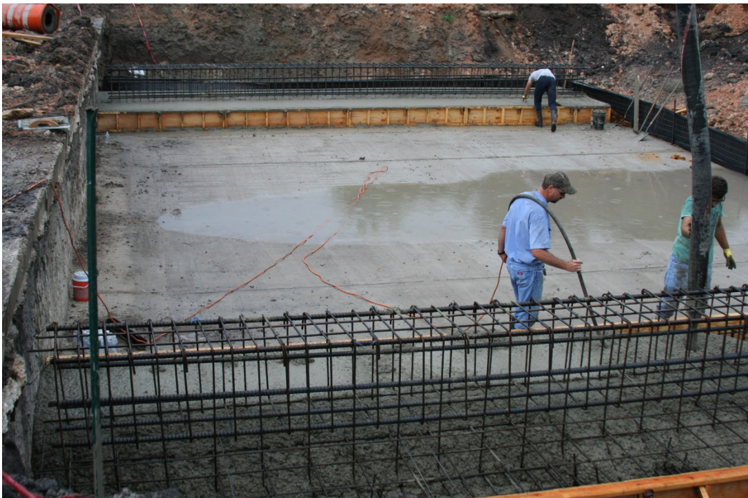
(b) Footing Concrete Pour
