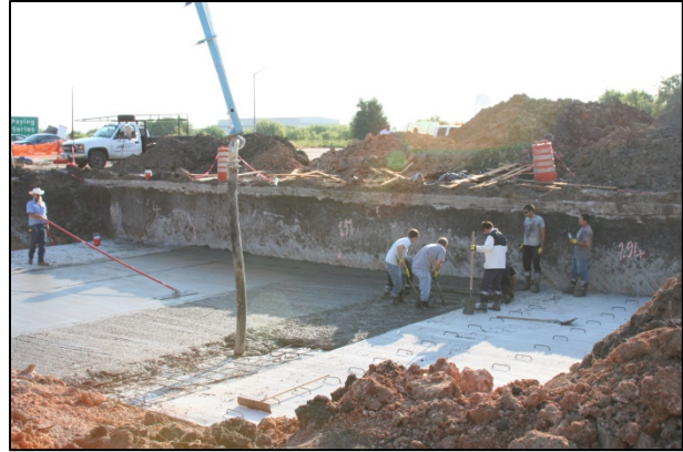
(b) Slab-on-Grade Pour
