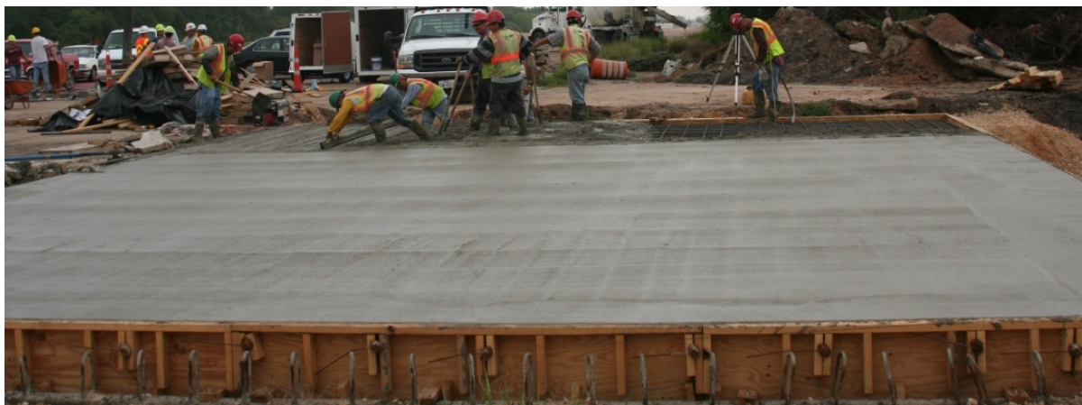
(c) Deck Concrete Pour
