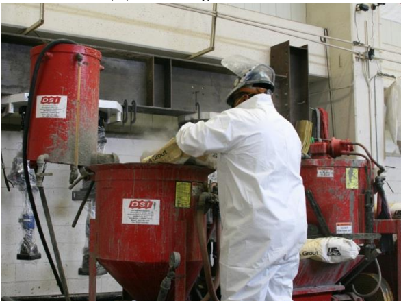
(d) Mixing Grout Mix and Water
