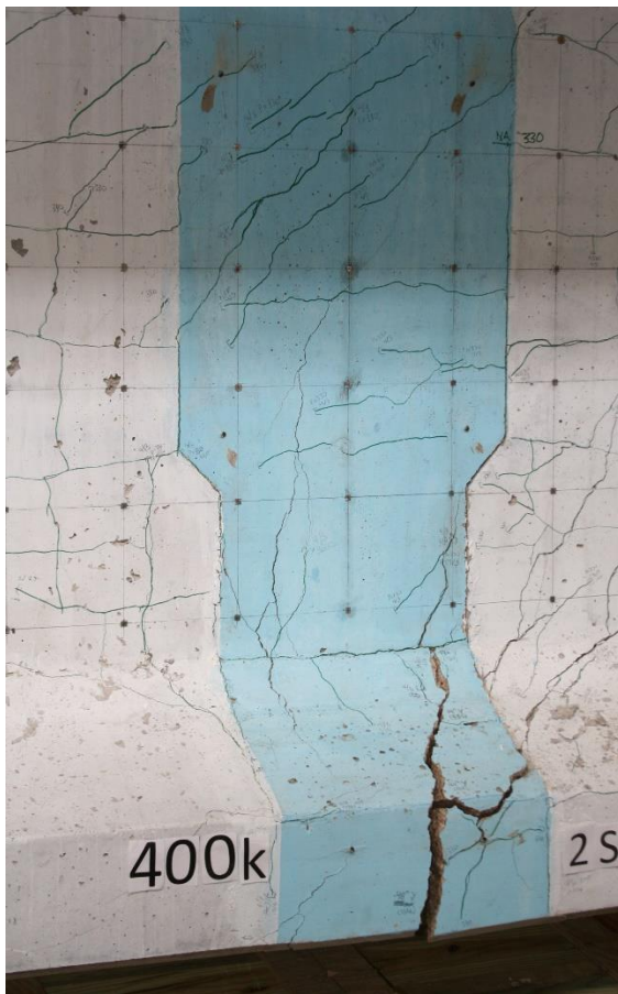
(d) Splice 2 - Failure at P = 400 kips
