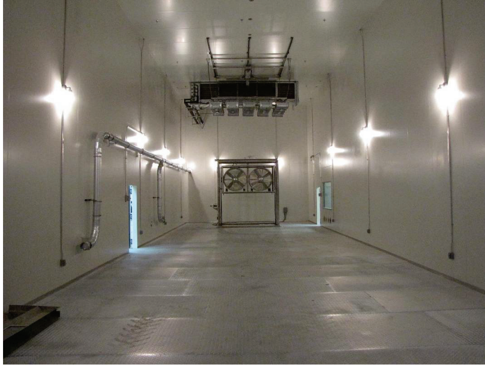
Figure 17. TTI's EERF Test Chamber.
