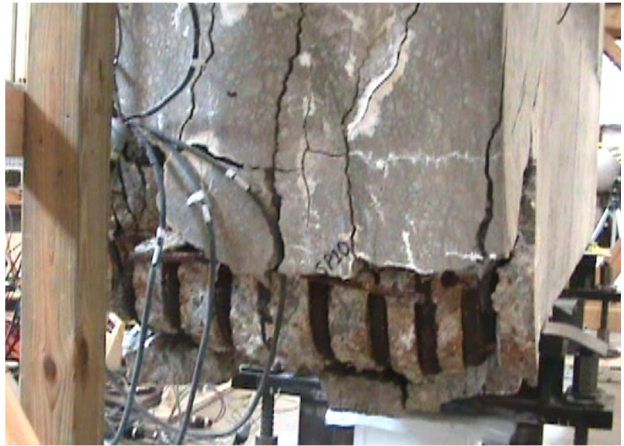
(d) Just after Failure
