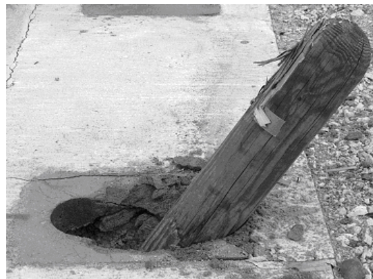
(d) Wood Post in Grout-Filled Leave-Out
