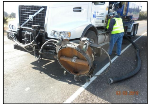
(d) Truck mounted UHP water cutting unit
