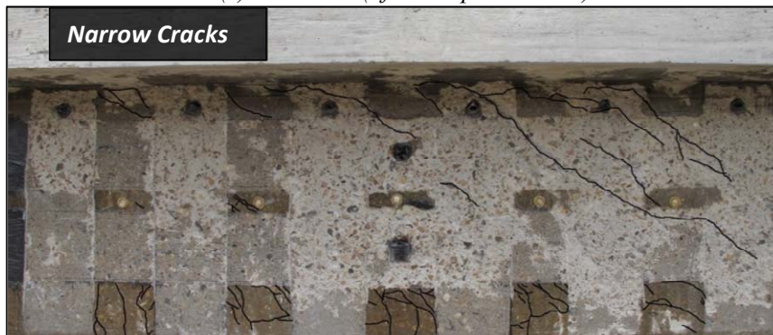
(d) 24-3-8-3 (after strips removed)
