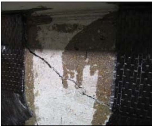
(d) Critical crack
