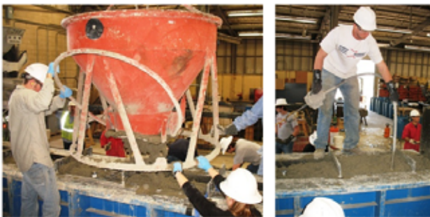
(d) Place concrete
