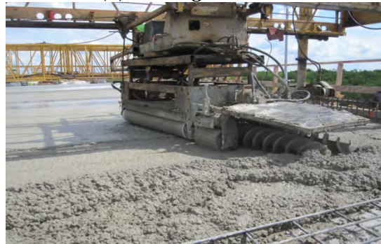
(d) Finishing surface
